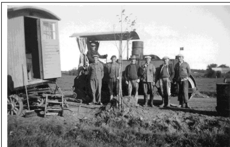
Tromleholdet ved Vejlevejs asfaltering, 1948.
