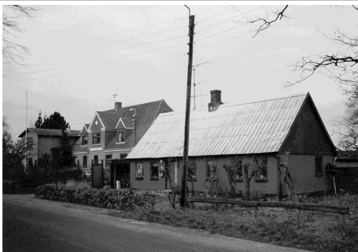
Barrit Langgade 23 og 25, 1989.
